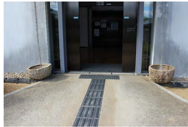
酒蔵館 受付棟出入口(自動ドア) (幅:138cm)
