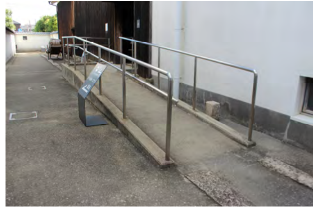
酒蔵 出入口スロープ (幅:100cm)
